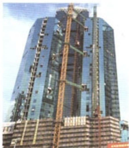
图 3-31 钢筋混凝土常用来建造高楼大厦
