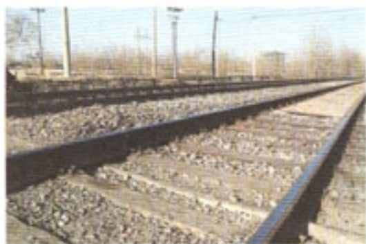
图 3-4 用锰钢（一种合金钢）制成的钢轨
