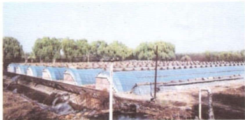
图 3-36 用热塑性塑料制成的薄膜大棚
