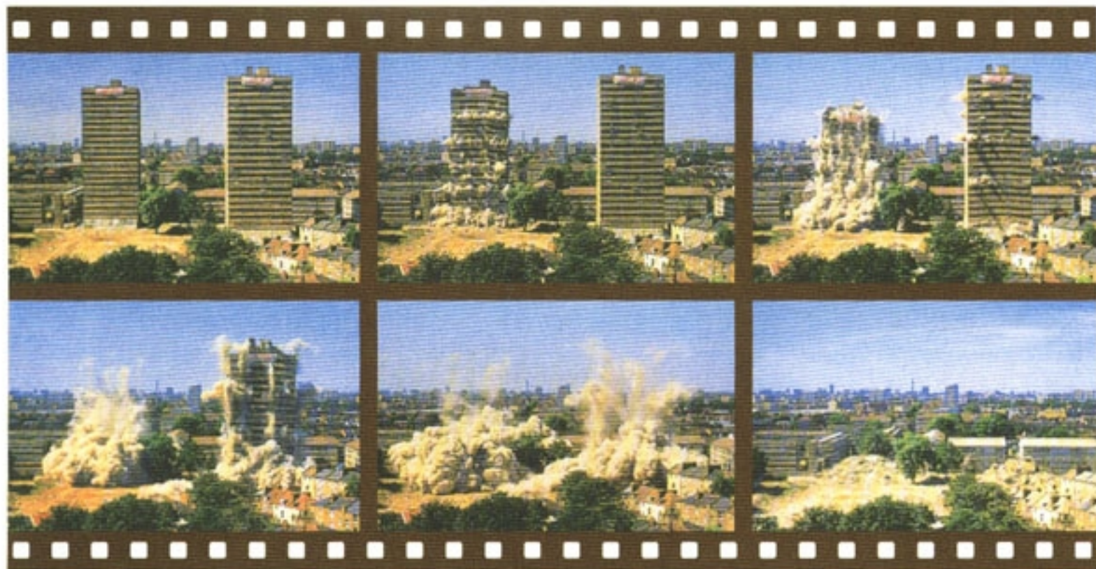
图 2-21 建筑物的定向爆破
